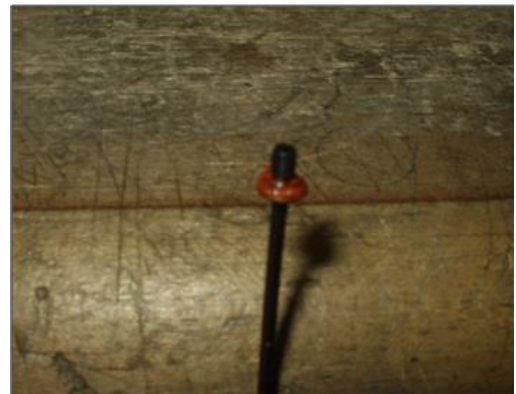
Рис. 34 Обработка винтовой заглушки герметиком
