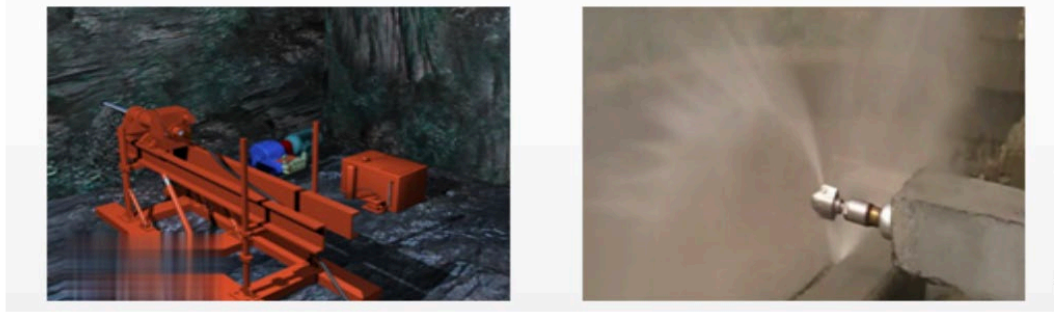
(a) 钻孔施工
