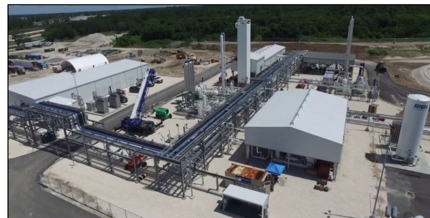
Модульный завод по производству СПГ на 75 тыс. т/г
