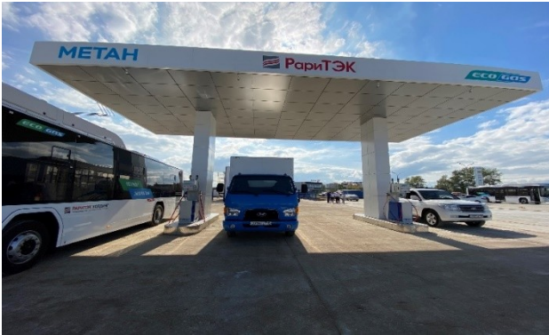
Автомобильная газонаполнительная компрессорная станция (АГНКС)
