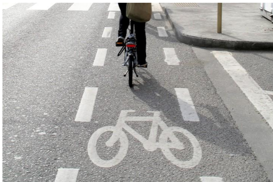
Marques routières matérialisant une bande cyclable, en Belgique (© Fédération européenne des cyclistes)
