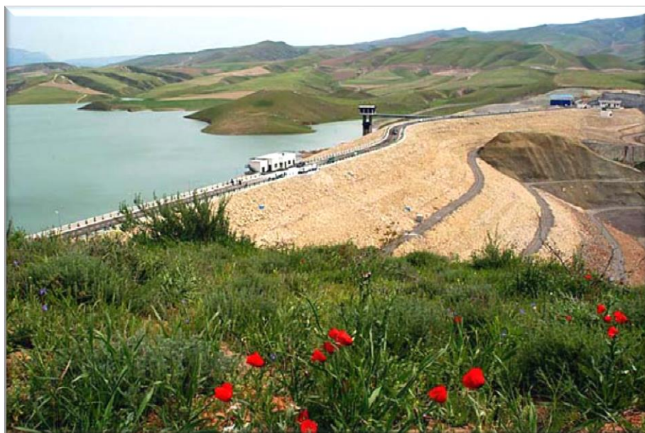
Рис. 4. Совместная Ирано- Туркменская водохранилищная плотина на реке Теджен/Герируд
