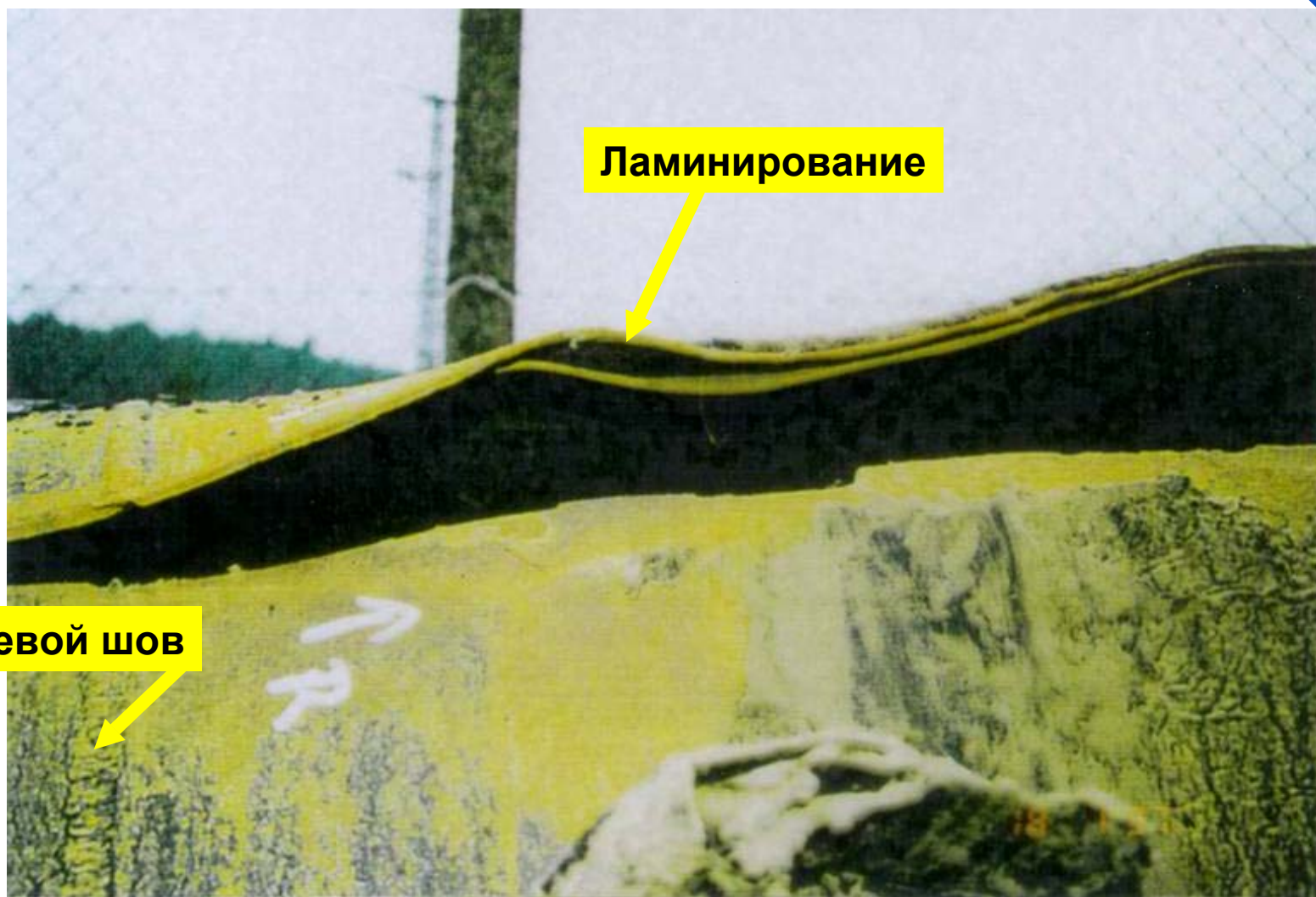
Пример разрушения из-за ламинирования
