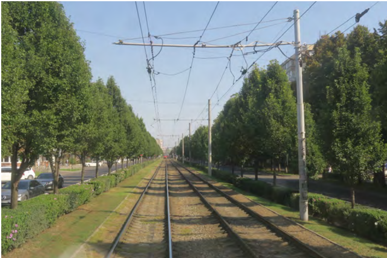
РИС. 3.2 КРАСНОДАР, РОССИЙСКАЯ ФЕДЕРАЦИЯ. ДАННАЯ ЛИНИЯ ЛЕГКОГО РЕЛЬСОВОГО ТРАНСПОРТА РАСПОЛОЖЕНА ПО ОСЕВОЙ ЛИНИИ ПРОСПЕКТА, ЧТО СОКРАЩАЕТ КОЛИЧЕСТВО ПЕРЕСЕЧЕНИЙ И ПОВЫШАЕТ СКОРОСТЬ ДВИЖЕНИЯ ТРАМВАЙНЫХ ПОЕЗДОВ. ПО ЭКОЛОГИЧЕСКИМ И ЭСТЕТИЧЕСКИМ СООБРАЖЕНИЯМ ЛИНИЯ ОКРУЖЕНА ДЕРЕВЬЯМИ. КУСТАРНИКИ СОЗДАЮТ ЗЕЛЕНое ОГРАЖДЕНИЕ, ЧТО СПОСОБСТВУЕТ БЕЗОПАСНОСТИ И ВЫСОКОСКОРОСТНОМУ ДВИЖЕНИЮ
