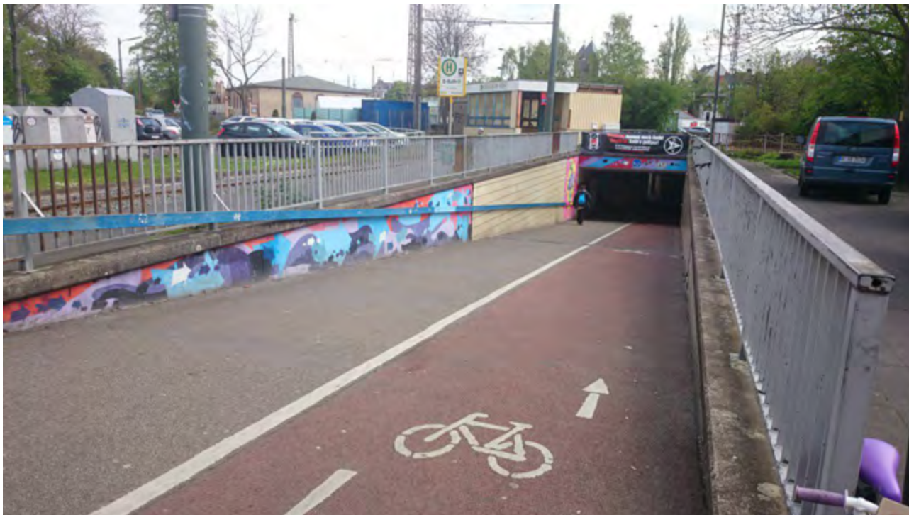
РИС. 3.9 ДЮССЕЛЬДОРФ, ГЕРМАНИЯ. ПЕРЕСЕЧЕНИЕ НА РАЗНЫХ УРОВНЯХ ВЕЛОСИПЕДНОЙ ПОЛОСЫ И ЖЕЛЕЗНОЙ ДОРОГИ ОБЕСПЕЧИВАЕТ БЕЗОПАСНОСТЬ И УДОБСТВО ЕЗДЫ ДЛЯ ВЕЛОСИПЕДИСТОВ
