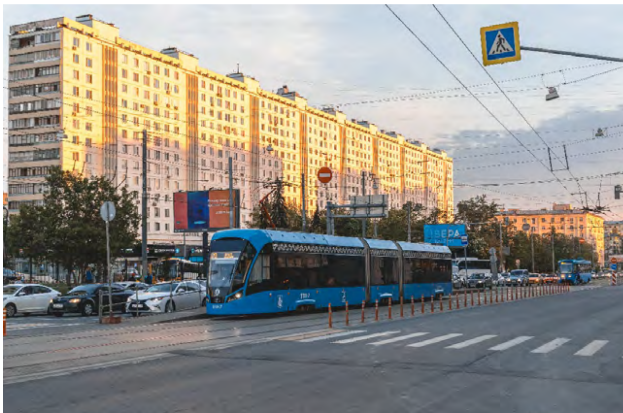
РИС. 3.43 МОСКВА. ТРАМВАЙНАЯ ЛИНИЯ ОТДЕЛЕНА ОТ АВТОМОБИЛЬНЫХ ПОЛОС ДЕЛИНИАТОРАМИ
