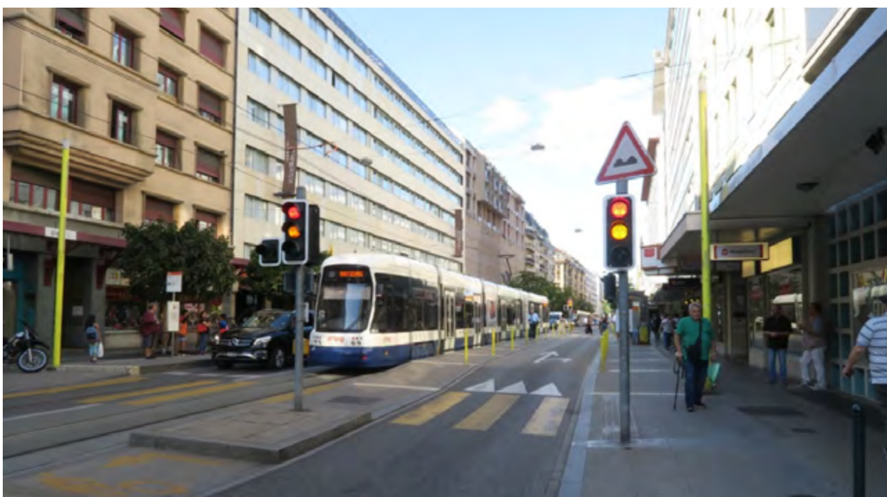
РИС. 3.46 ЖЕНЕВА. ДОРОЖНОЕ ПОКРЫТИЕ В МЕСТЕ ОСТАНОВКИ ТРАМВАЯ ПРИПОДНЯТО ДО УРОВНЯ ПЛАТФОРМЫ, ЧТО ОБЛЕГЧАЕТ ПОСАДКУ Пассажиры В ТРАНСПОРТ, А ТАКЖЕ ОБЕСПЕЧИВАЕТ БЕЗОПАСНОСТЬ ПРИ ПОСАДКЕ И ПРИОРИТЕТНОСТЬ ДВИЖЕНИЯ ТРАМВАЯ. ДАННЫЙ ТИП ТРАМВАЙНОЙ ПЛАТФОРМЫ НАЗЫВАЕТСЯ «ВЕНСКАЯ ПЛАТФОРМА»
