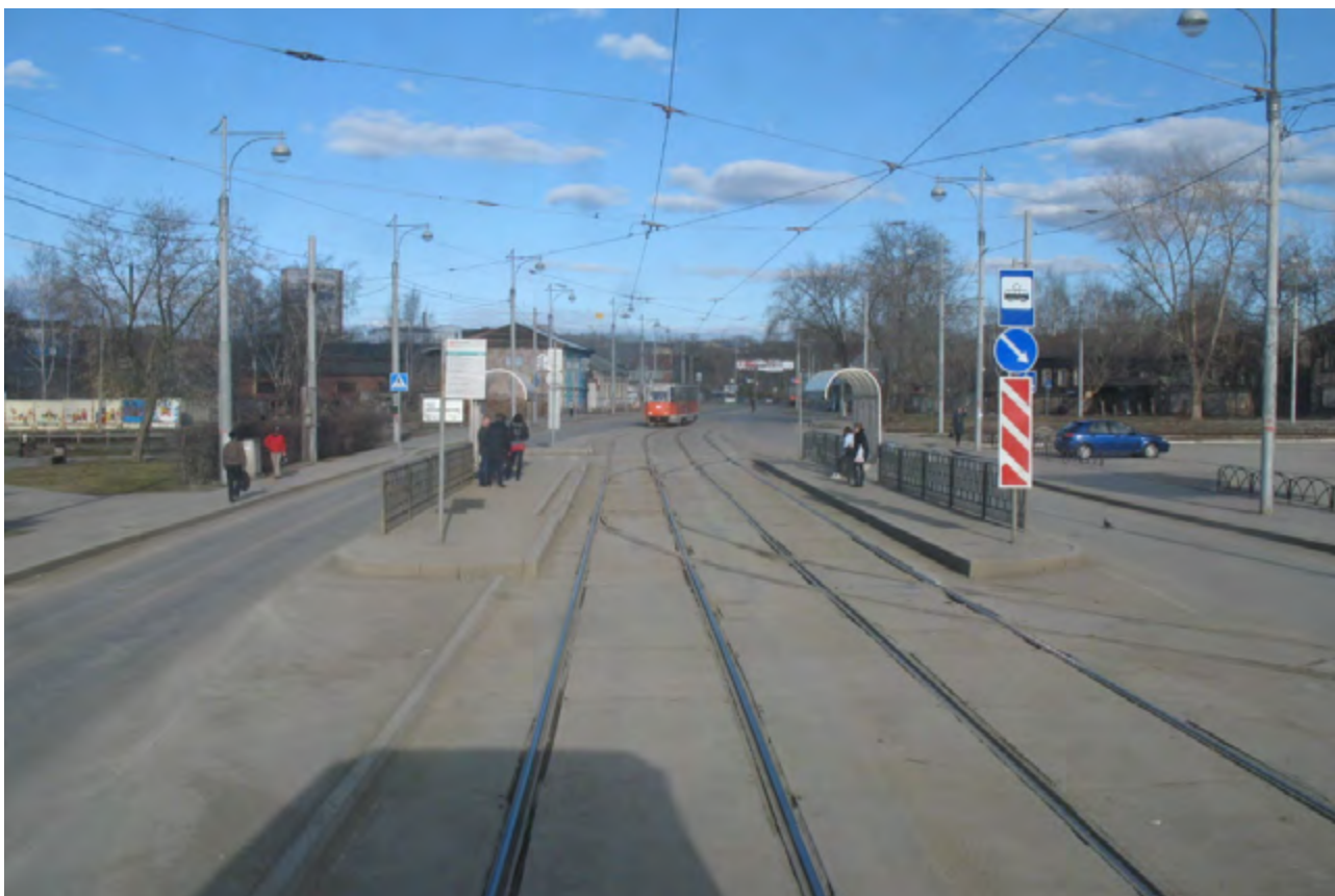
РИС. 3.42 ПЕРМЬ. ТРАМВАЙНАЯ ОСТАНОВКА ЗА ПРЕДЕЛАМИ ЦЕНТРА ГОРОДА ОБОРУДОВАНА ОСТРОВНЫМИ ПОСАДОЧНЫМИ ПЛАТФОРМАМИ, КОТОРЫЕ ОБЕСПЕЧИВАЮТ БЕЗОПАСНУЮ ПОСАДКУ В ТРАМВАЙ ДАЖЕ НА УЗКИХ УЛИЦАХ. ОБРАТИТЕ ВНИМАНИЕ, ЧТО ПЛАТФОРМА РАЗМЕЩЕНА НА ВНЕШНЕЙ СТОРОНЕ КРИВОЙ
