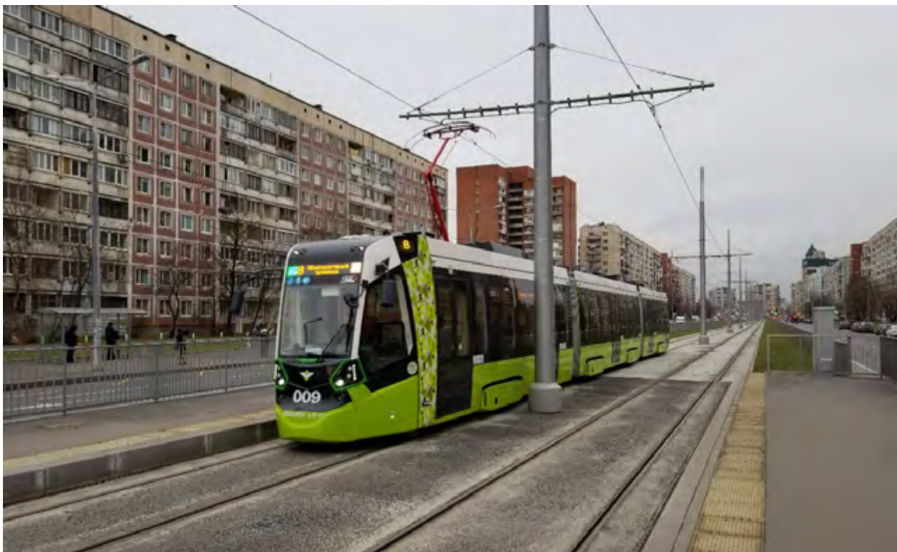
РИС. 3.52 САНКТ-ПЕТЕРБУРГ. РЕКОНСТРУКЦИЯ ТРАМВАЙНОЙ ЛИНИИ В КРАСНОГВАРДЕЙСКОМ РАЙОНЕ ПО СТАНДАРТАМ ЛЕГКОГО РЕЛЬСОВОГО ТРАНСПОРТА БЛАГОДАРЯ ГОСУДАРСТВЕННО-ЧАСТНОМУ ПАРТНЕРСТВУ
