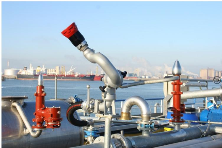
Mit Strahl-/Sprührohr versehene Wasserentnahmeanschlusstelle – mit ausreichend langem Schlauch. Die Schläuche könnten vollständig durch eine feste Wasserleitung ersetzt werden. Allerdings muss nach den derzeitigen Rechtsvorschriften ein Schlauch vorhanden sein.
