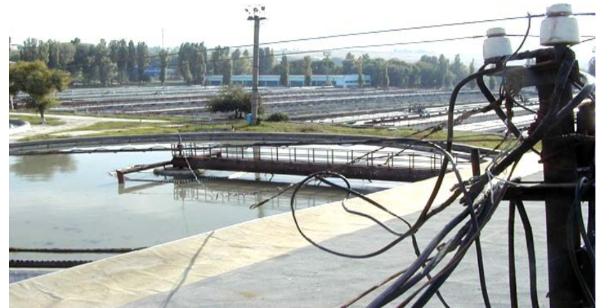
Decantoare primare radiale – 6 buc. (D-40m și V-4500m 3 )
