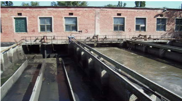
Deznisipatoare horizontale cu 4 secții
