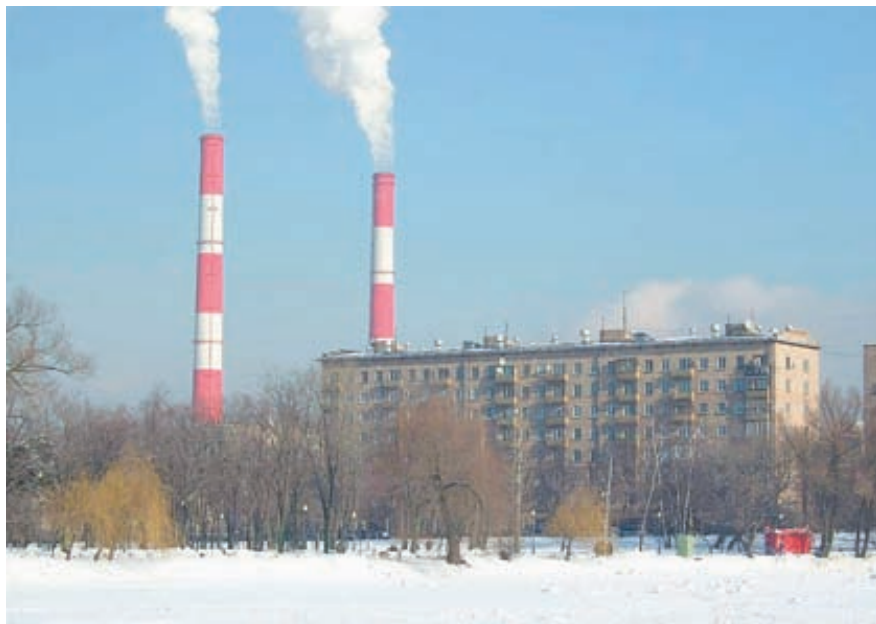
Фото 6. Электростанция в жилом районе Москвы, февраль 2009 года.
