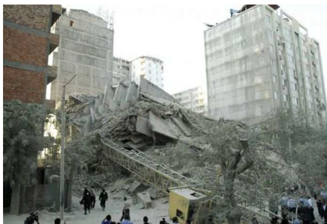
Рисунок 14. Разрушенное здание в Баку, август 2007 г. Источник: Day.az
