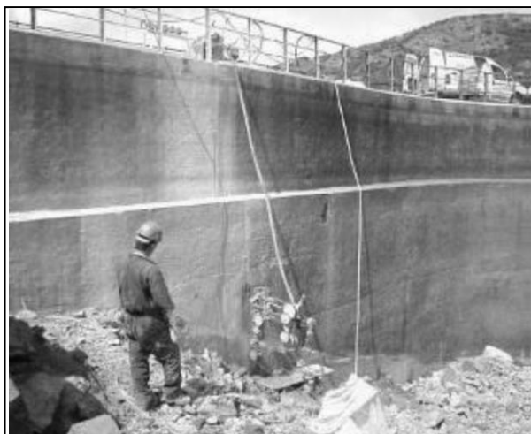
Рис. 13. Разрезание с помощью алмазной ленты и вывод из эксплуатации левой грани плотины Коронджу II для размещения нового водосброса
