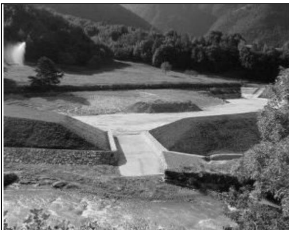
Рис. 6. Вид фактического состояния работ
