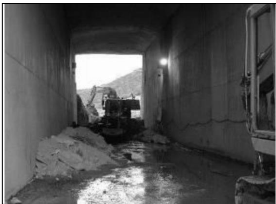
Рис. 9. Строительные работы по направлению воды через контрфорсы разбираемого свода
