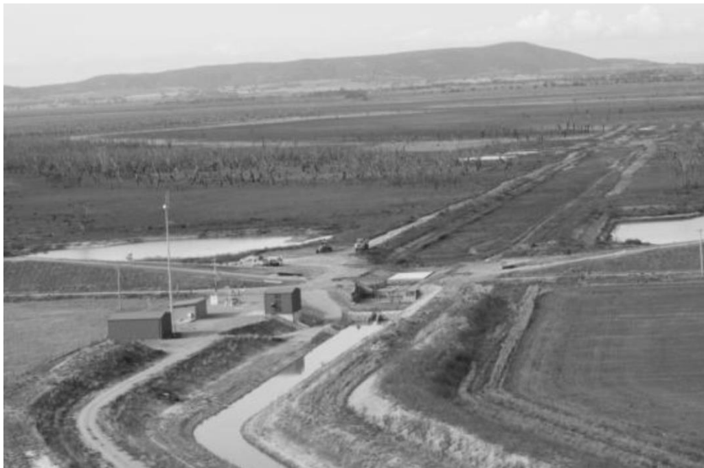
Рис. 1 Разборка дамбы, отводные каналы из озера с насосной станцией (на переднем плане), осушенное дно озера Мокоеен (на заднем плане)
