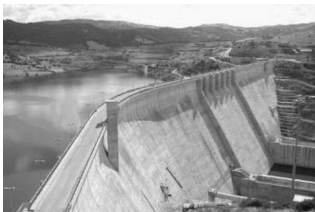
Рис. 8. Плотина Ла Кантоньера (La Cantoniera) со стороны правого берега
