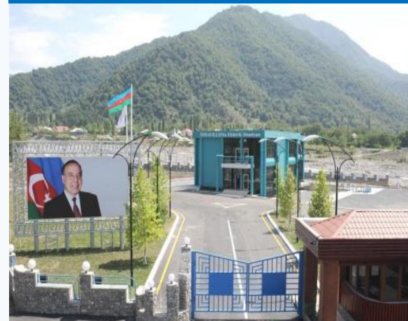
ГЭС «Ismayilli», 1.6 МВт
