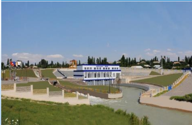
ГЭС «Goychay», 3 МВт
