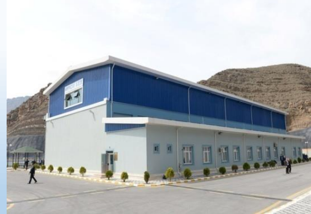
ГЭС «Arpachay», 20.5 МВт
